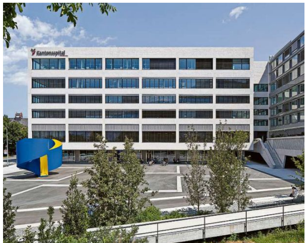
Das Haus H1 des Kantonsspitals in Chur mit Haupteingang und vorgelagertem Spitalplatz.
